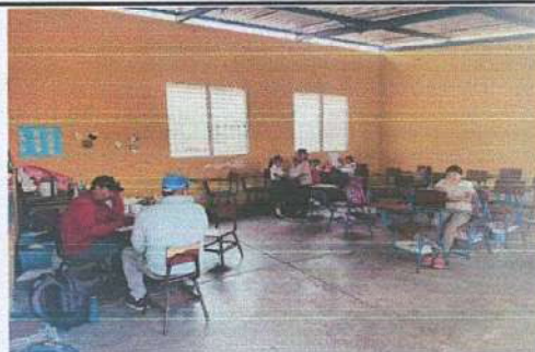
Foto 2: PINTURA DE TODA LA ESCUELA, 512 MTS2.
