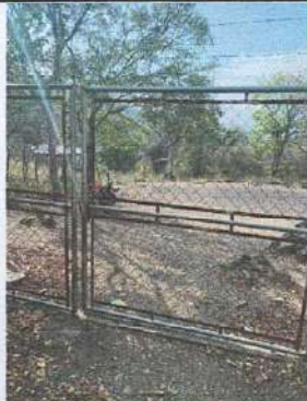
Foto1: Reparación de malla en mal estado en el portón de 3x2mts.
