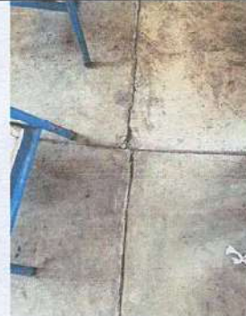
Foto 2: REPARACION DE TORTA DE CONCRETO DE UN AULA.
