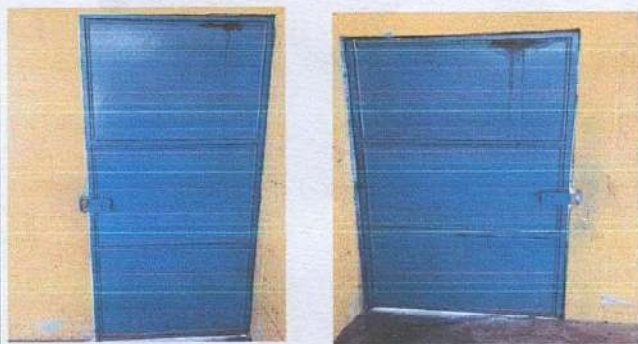
Foto 3: MANTENIMIENTO E INSTALACION DE CHAPAS YALE, CON DOS JUEGOS DE LLAVES.
