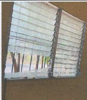
Foto 3: SUSTITUCIÓN DE PALETAS DE VENTANAS, INCLUYE RETIRAR PALETAS EN MAL ESTADO
