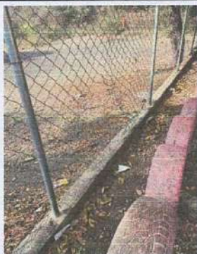
Foto 1: SUSTITUCION DE MALLA EN MAL ESTADO, 55.60 MTS2.
